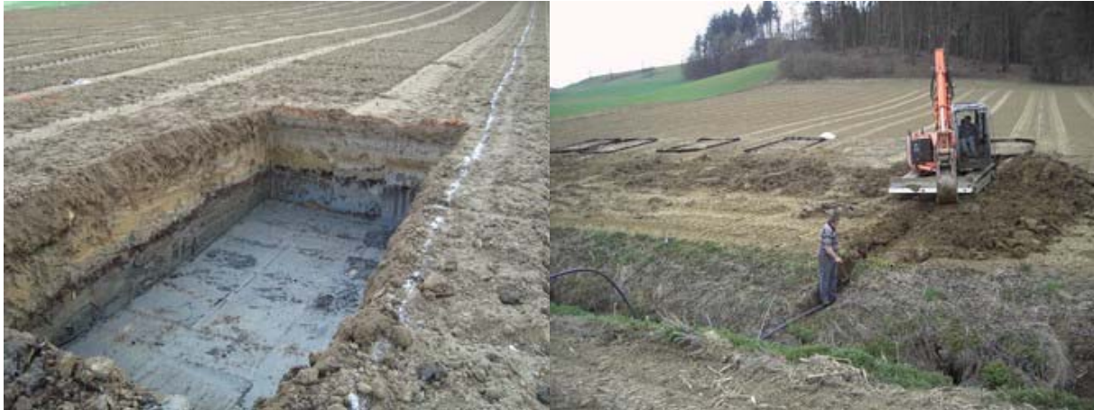
Abbildung 48 und 49: Aushub für ein Folienbecken und Errichtung der Ableitung.
