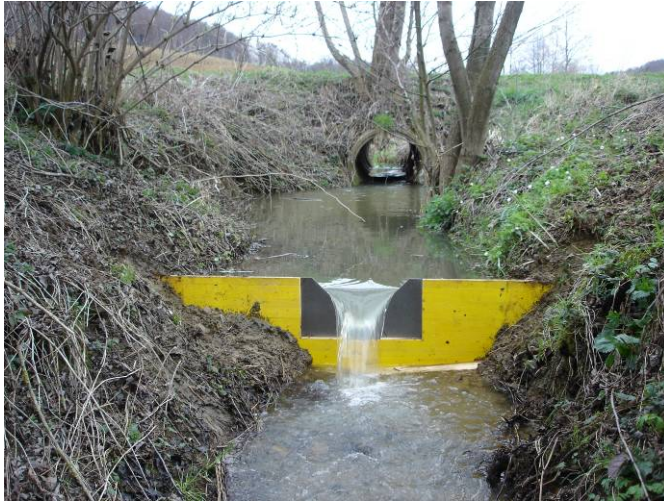
Abbildung 33: Messwehr am Auersbach.
