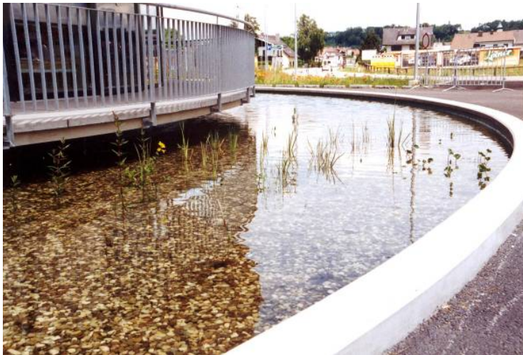
Abbildung 12: Wasserkanal der Regenwassernutzungsanlage.
