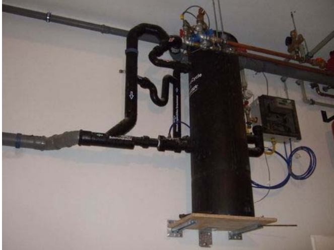
Abbildung 29: Grauwasserwärmetauscher.
