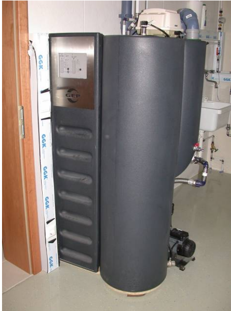
Abbildung 24: Grauwasserreinigungsanlage.
